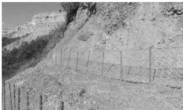
Banquettes grillagées Col du Corbin
