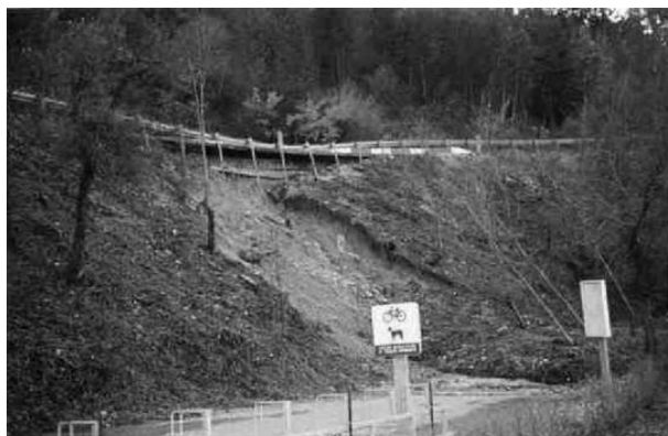
Glissement de terrain Digne les Bains
