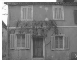
1. Enduit jeté et recoupé à pierres vues (La Palud-sur-Verdon) 2. Enduit jeté au balai (Valensole) 3. Enduit à la tyrolienne au mortier à gros grain teinté à l'oxyde métallique (Allions)
