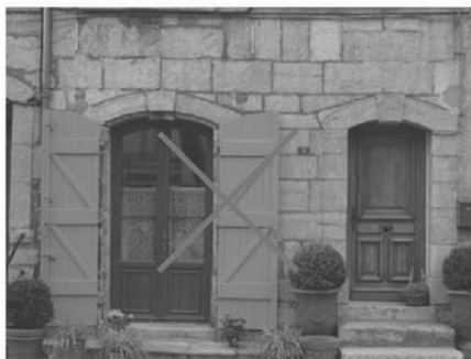
Harmonie des teintes de menuiseries inversée (à proscrire)
