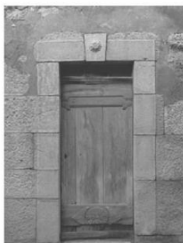
Soubassement et encadrement de porte en pierre calcaire froide taillée (La Garde)
