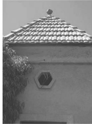
Tuiles plates mécaniques (cabanon à Riez)
