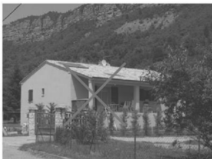
Enduit de teinte trop soutenue (à proscrire)
