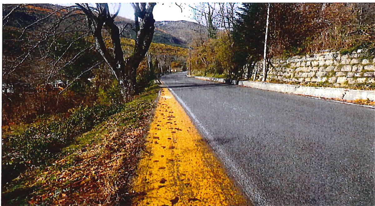
La voie piétonne passe de 80 cm environ à 20 cm le long du mur hauteur de + d'1 m
