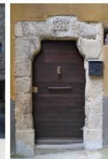
DÉTAIL ENCADREMENT PIERRE
