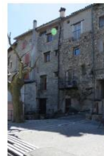
FAÇADE SUR PLACE DU COULET
