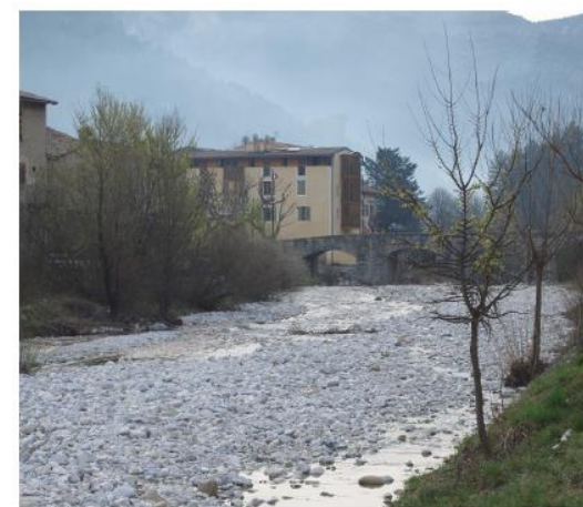
LE TORRENT DE LA VAÏRE, LES DIGUES ET LE PONT
