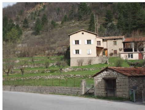
CLÔTURE HAMEAU DE SCAFFARELS
