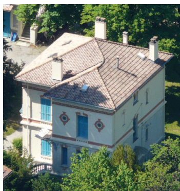
Immeuble à caractère exceptionnel richement décoré, isolation extérieure impossible
