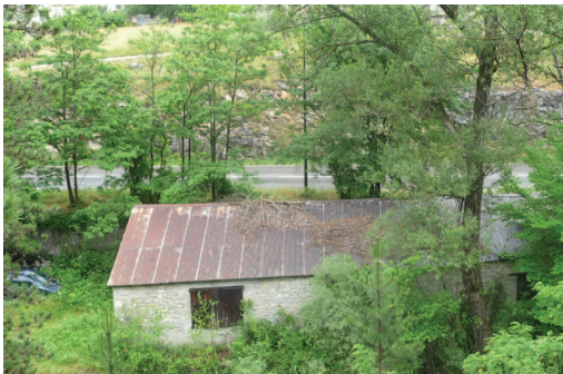
BÂTI DANS LE LIT DE LA VAÏRE
