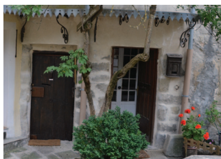
Encadrement portes pierre de taille
