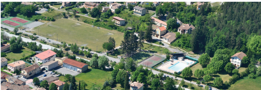
BÂTI A VOCATION D'ÉQUIPEMENT EN BORDURE DE VAÏRE
