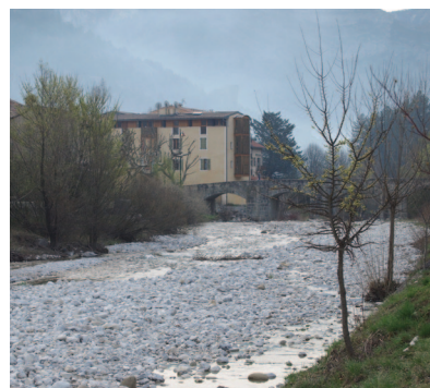
LE TORRENT DE LA VAÏRE, LES DIGUES ET LE PONT
