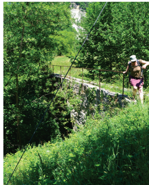
PONT SUR LA BEÏTE
