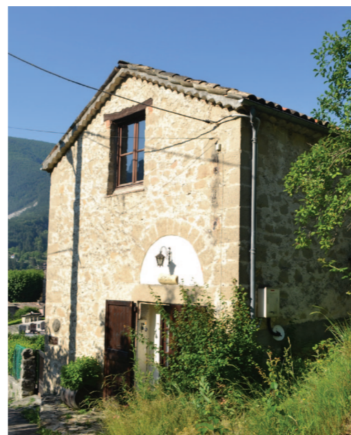
BÂTI ANCIEN EN BORDURE DE VOIE
