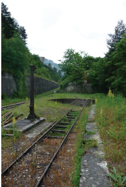
VOIE FERRÉE ET PLATE-FORME DE RETOURNEMENT
