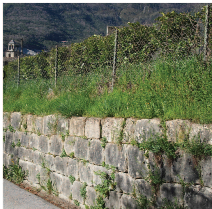
Structure d'un mur de soutènement en pierres sèches. Fabienne Méline, PNR Préalpes d'Azur.
