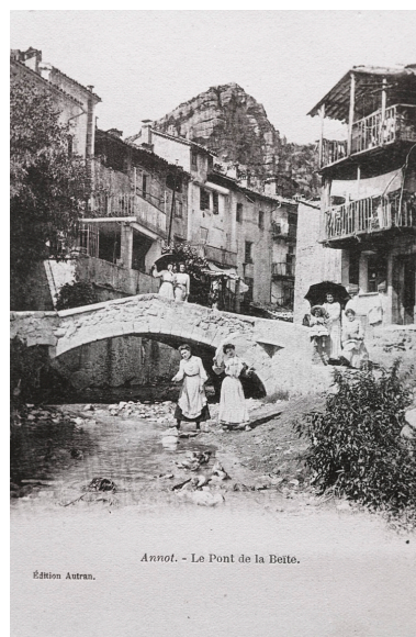
Annot. - Le pont de la Beïte. IVR93_20110400121NUC2A
