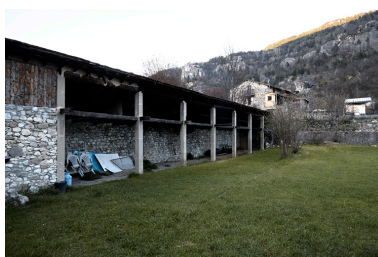
Un entrepôt agricole. Phot. Frédéric Pauvarel IVR93_20170400486NUC2A
