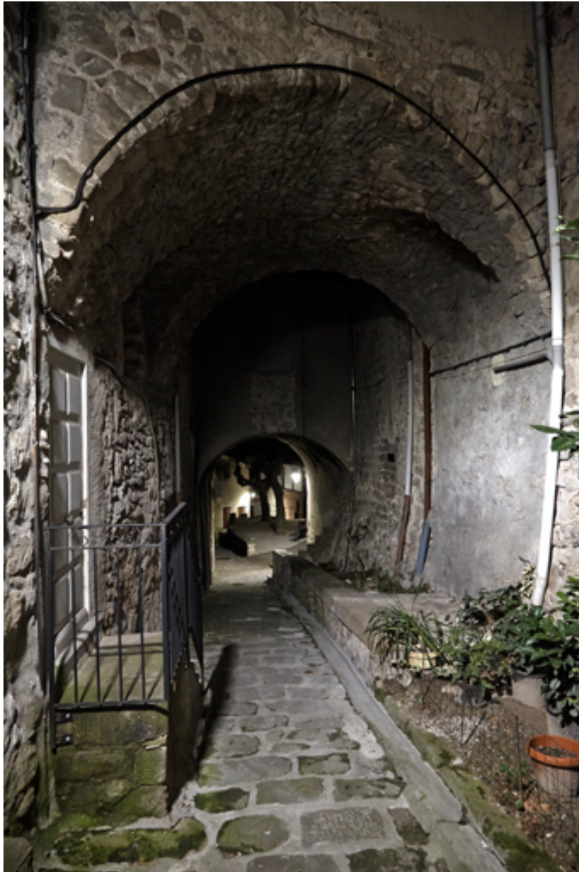
Passage couvert rue des moulins.
