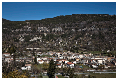
Le village dominé par le viaduc ferroviaire. Phot. Frédéric Pauvarel IVR93_20170400471NUC2A
