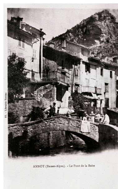
Annot (Basses-Alpes.). - Le Pont de la Beite IVR93_20110400113NUC2A
