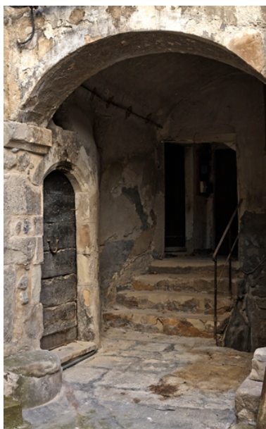
Un espace couvert en bas de la Grand Rue. Phot. Frédéric Pauvarel IVR93_20170400468NUC2A
