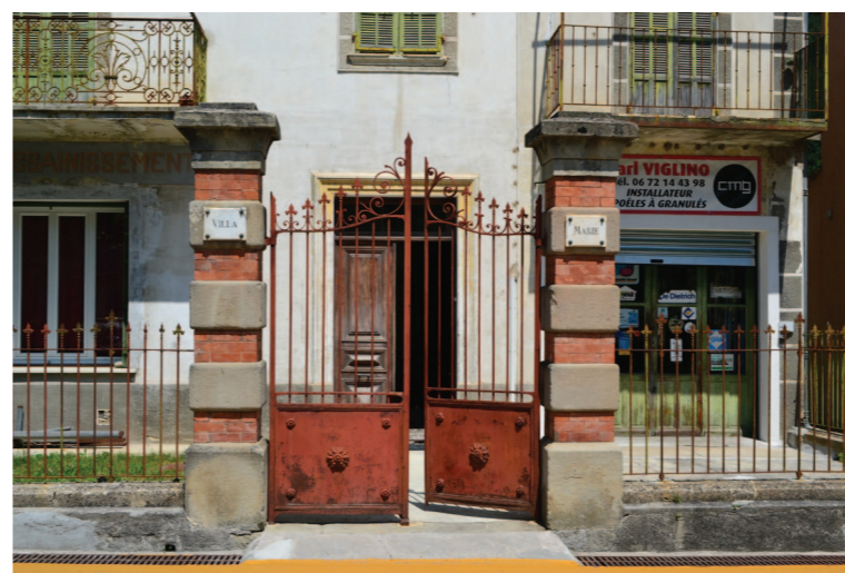
PORTAIL ET CLÔTURE
