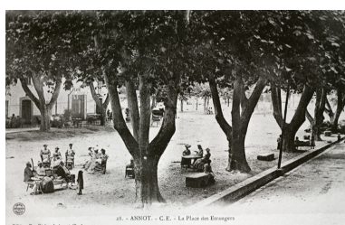
28. -Annot. - C.E. - La Place des Etrangers IVR93_20110400109NUC2A
