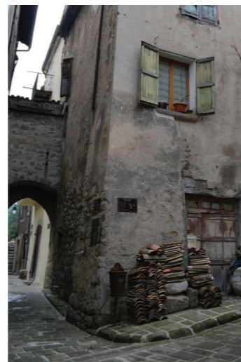
PARTIE DE PILIER DU PORTAIL DE LA ROUBINE - RUE ST JEAN
