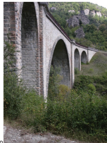
Viaduc du chemin de fer
