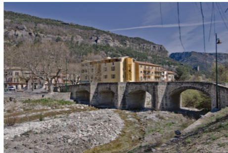
Pont de la Vaïre
