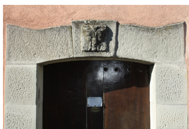
La forme de cet encadrement de porte est très présente à Annot tout au long du 19e siècle. La clé adopte ici (rue du Peyrard) un motif de masque-feuille. Phot. Géraud Buffa IVR93_20170400535NUC2A
