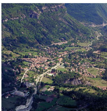
Vue aérienne oblique depuis le nord-ouest. Phot. Marc Heller IVR93_20060402303XE
