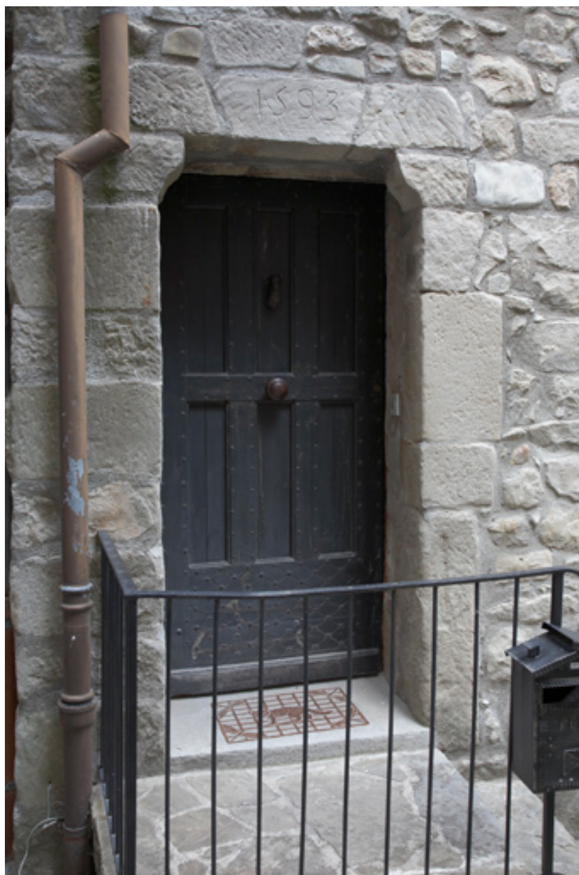
Porte refaite à la fin du 20e siècle (parcelle 349)
