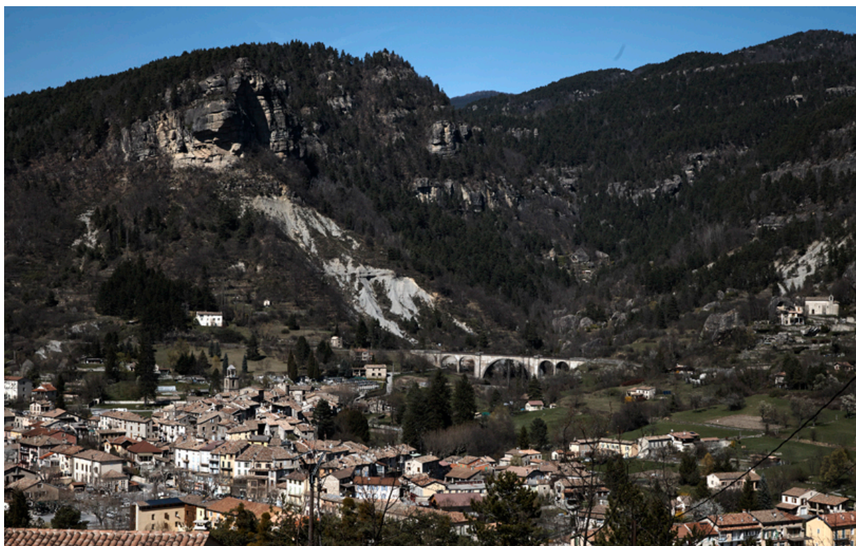
Le pont ferroviaire sur la Beïte avec à droite le site médiéval de Vers-la-Ville et à gauche le village déperché.
