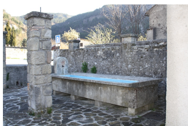
Lavoire en béton. Phot. Géraud Buffa IVR93_20170400536NUC2A
