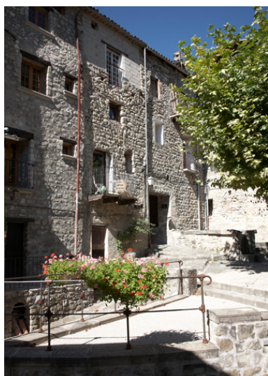
La rue des moulins : emplacement du moulin à farine détruit. Phot. Frédéric Pauvarel IVR93_20150402587NUC2A
