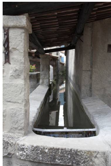
Le lavoire de la rue du Peyrard. Phot. Frédéric Pauvarel IVR93_20150402632NUC2A
