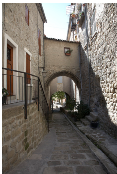
Passages couverts rue des moulins. Phot. Frédéric Pauvarel IVR93_20150402590NUC2A
