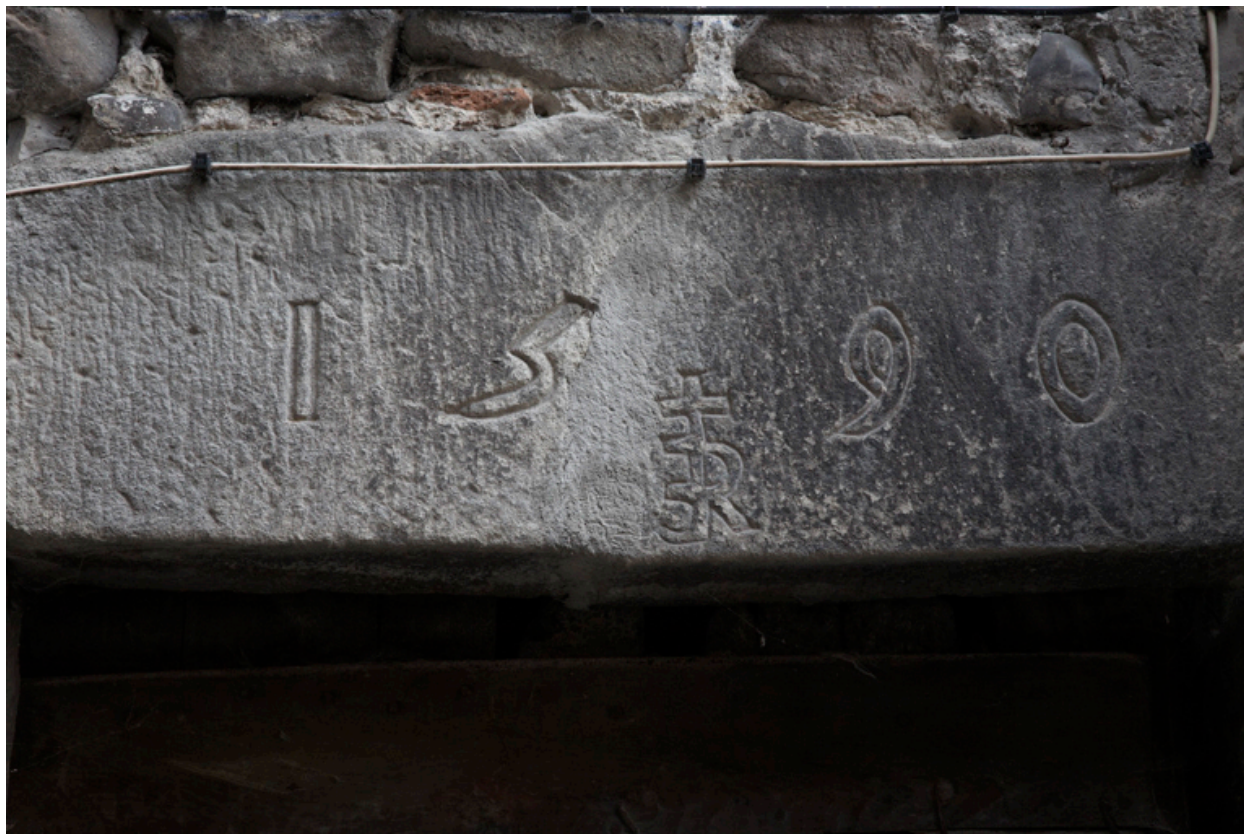
Porte rue du Four (maison Verdollin).
