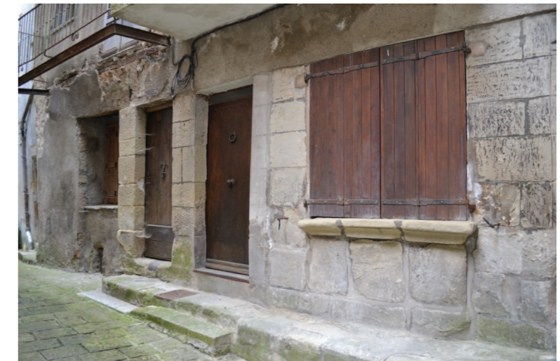
SOUBASSEMENT ET APPUI DE FENÊTRE
