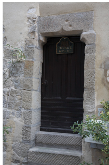
Porte avec Coussinets et linteau en accolade rue Notre-Dame. Phot. Frédéric Pauvarel IVR93_20150402642NUC2A
