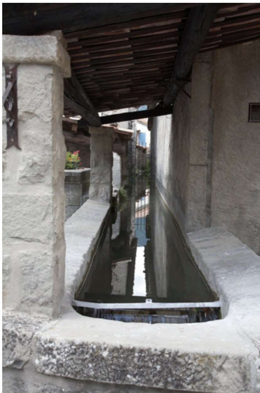
Le lavoir de la rue du Peyrard.
