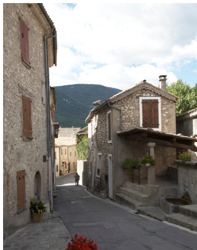
Le haut de la rue du Peyard avec le lavoir de la porte neuve Notre-Dame.
