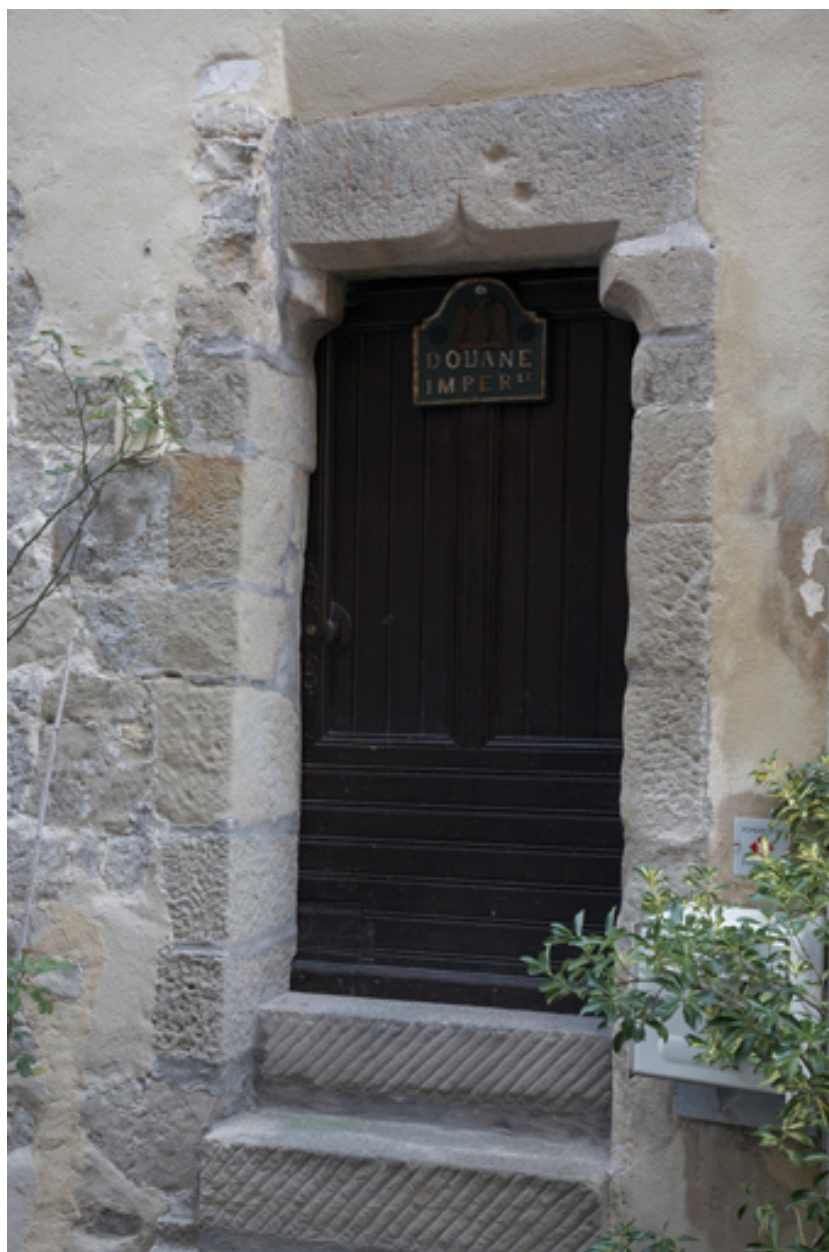
Porte avec Coussinets et linteau en accolade rue Notre-Dame.
