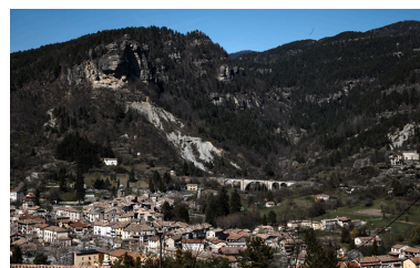
Le pont ferroviaire sur la Beite avec à droite le site médiéval de Vers-la- Ville et à gauche le village déperché. Phot. Frédéric Pauvarel IVR93_20170400521NUC2A
