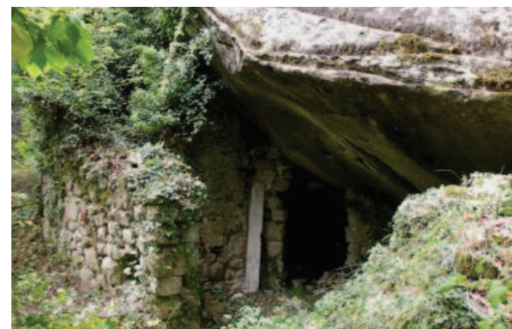
SOURCE PATRIMAGE : IVR93_20100401571NUC2A_T FERME PIGEONNIER ET LE SERRE
